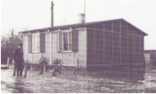
Gemeindebaracke Ecke Heppenbuschweg – Im Hoverfeld beim Hochwasser 1963. Heute bebaut mit Garagen.
