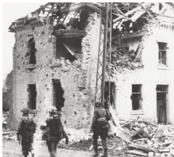
Zerstörtes Haus Ecke Buirer Str./Kirchstraße
