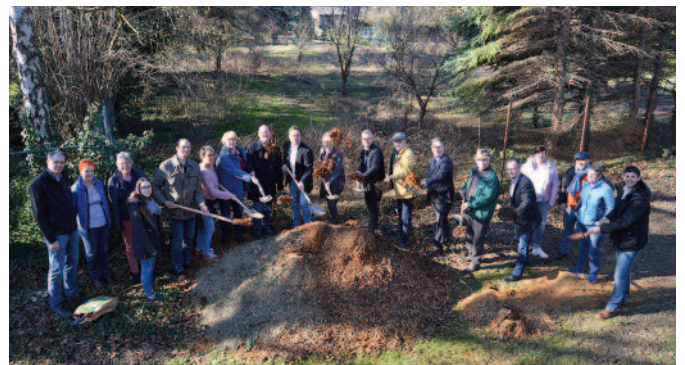
Spatenstich für "Bildung unter einem Dach" in Golzheim
