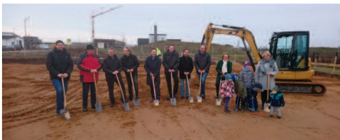
Spatenstich für die neue KiTa in Morschenich-Neu
